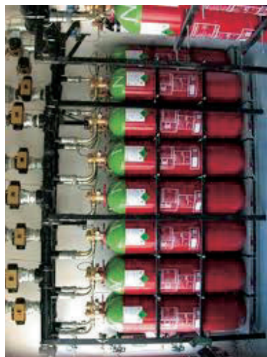
Impianto a gas chimici (es.: HFC-23)
