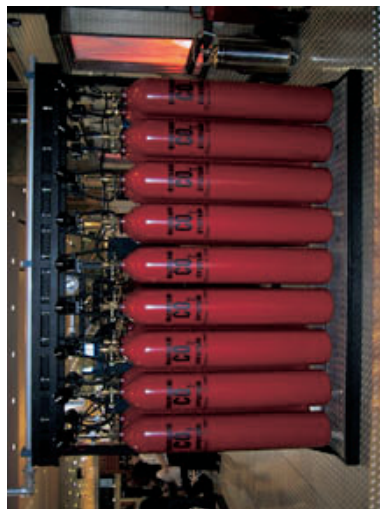
Impianto ad anidride carbonica
